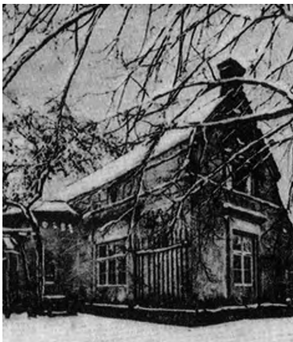
Fot. 2. Budynek nadleśnictwa na Bagatelce (XIX w.)
