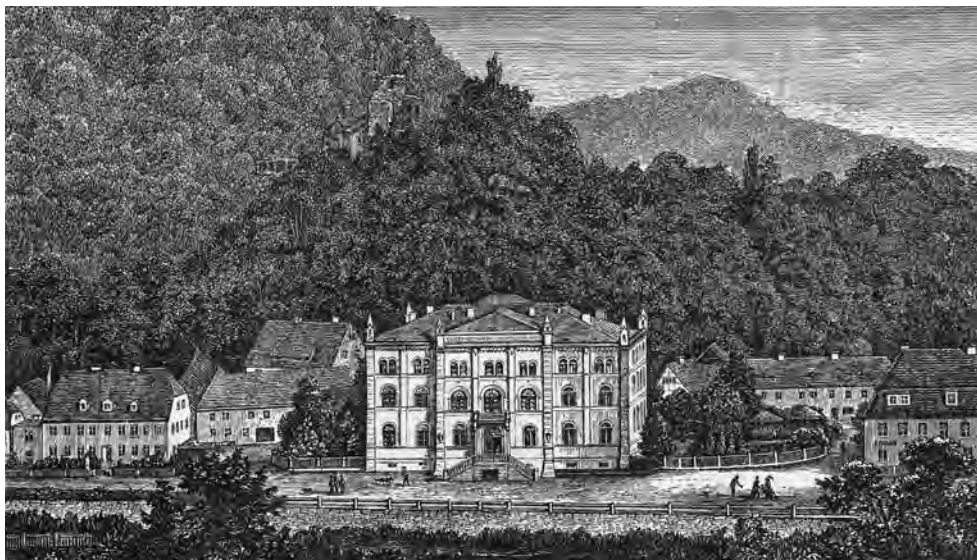
Ryc. 2. Najstarszy budynek Akademii Leśnej zbudowany w latach 1847-1849
